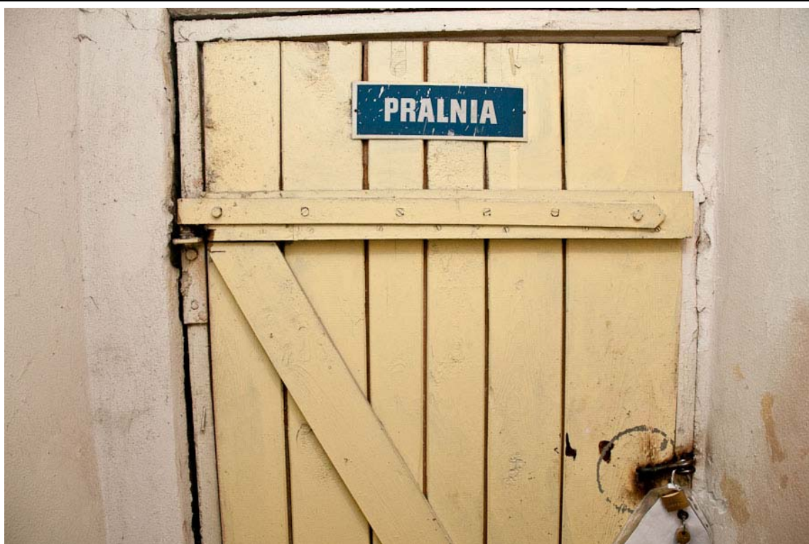
Zdj.4. Dobrym rozwiązaniem jest przeznaczenie na potrzeby kotów nieużywanego pomieszczenia piwnicznego, np. pralni (foto: Mariusz Pogorzelski)
